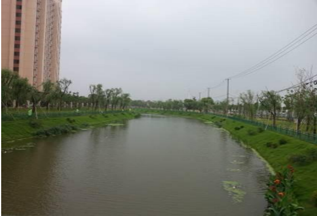
图 7-8 植生型生态混凝土护岸
