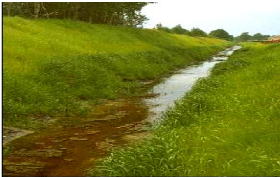
图 7-5 纯植被生态护岸
