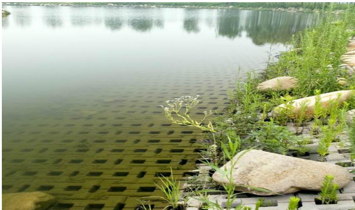
图 7-6 土工网垫植被护岸
