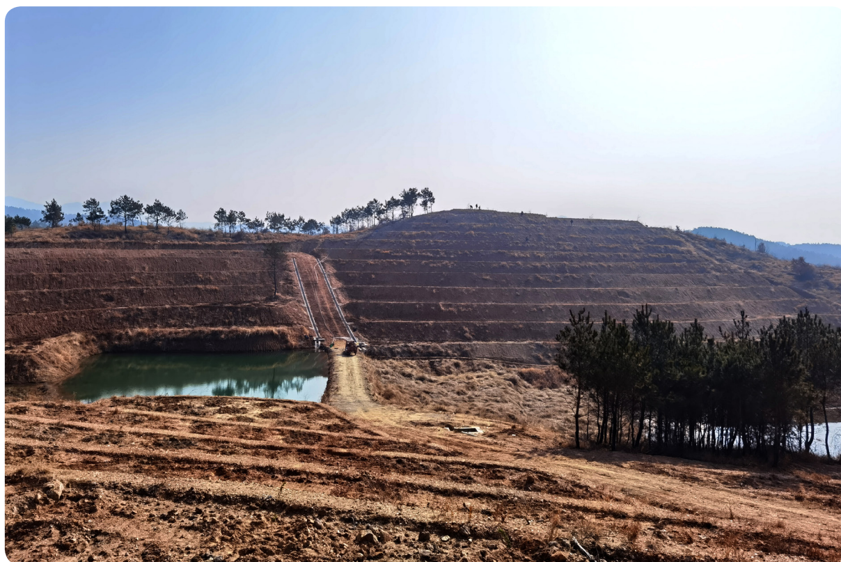
广水市 2021 年杜家河小流域治理项目 (坡改梯)
