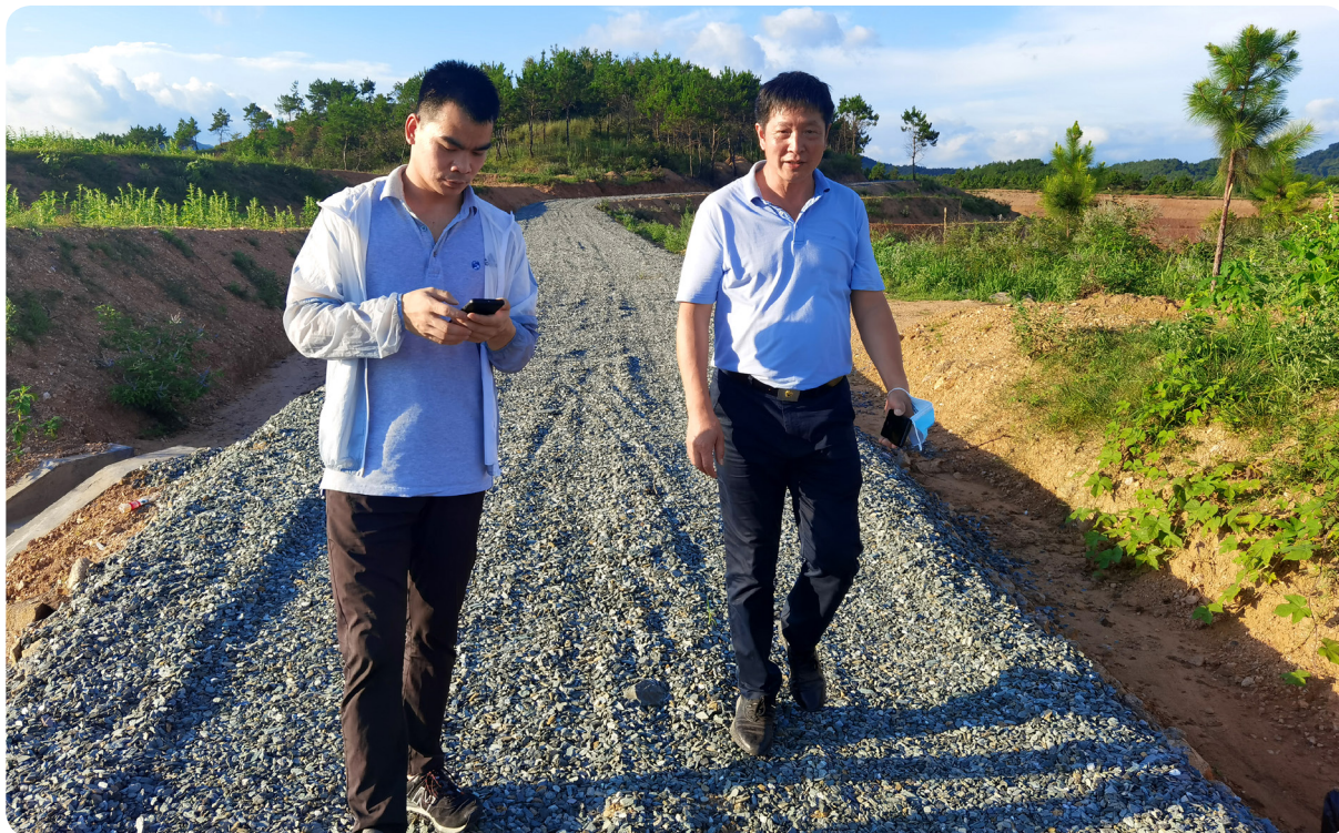
长江委现场核查 2021 年杜家河小流域水保现场
